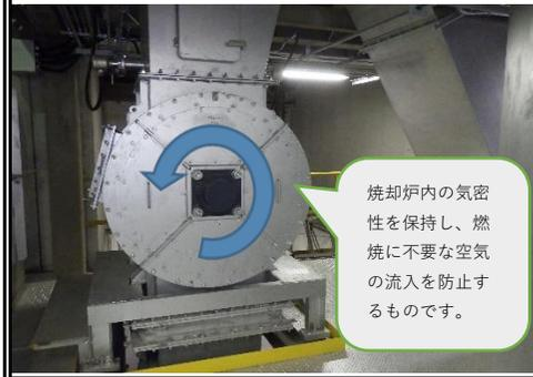
焼却炉内の気密性を保持し、燃焼に不要な空気の流入を防止するものです。
