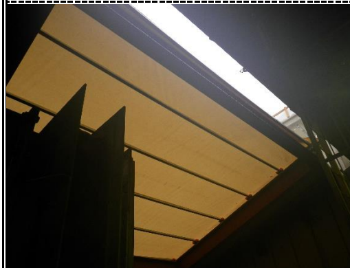
焼却炉耐火物解体後（下部から）
