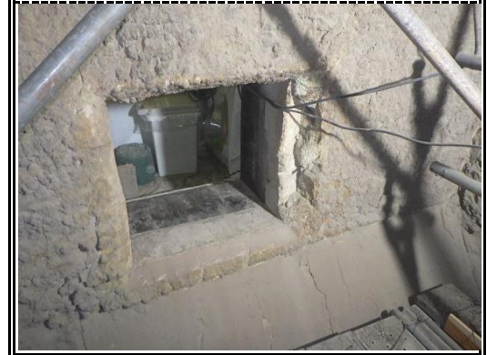
3号焼却炉下部耐火物解体
