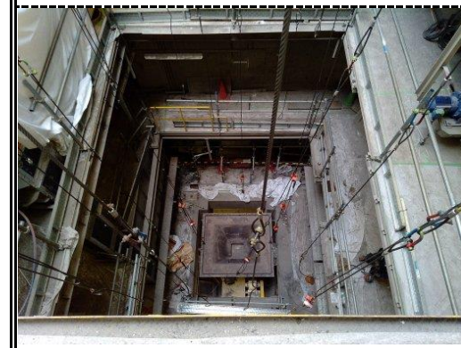
撤去物搬出（写真は調量機）
