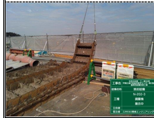
撤去物搬出（写真は調量機）
