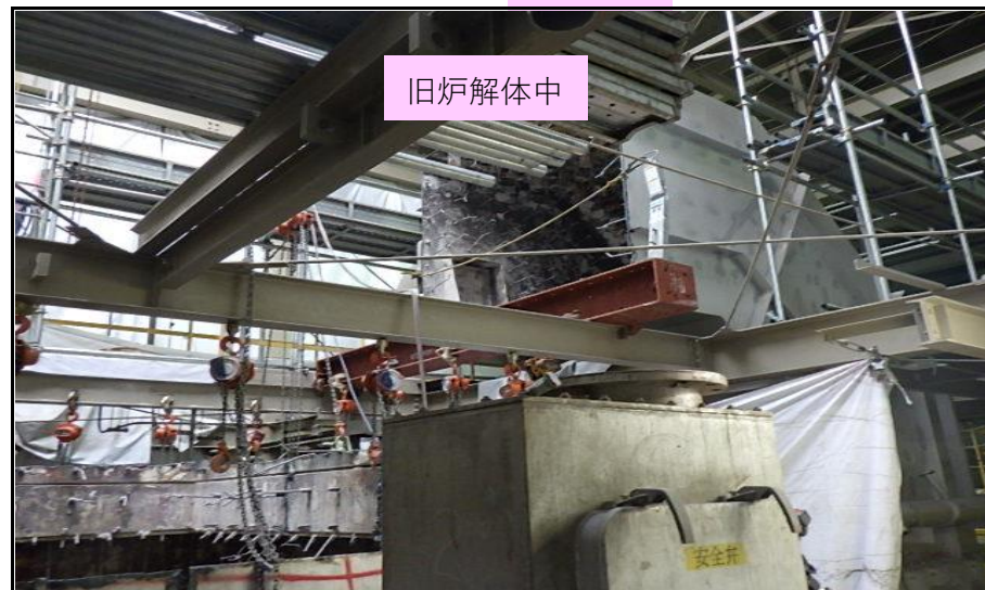
焼却炉上部から連絡ダクト撤去
