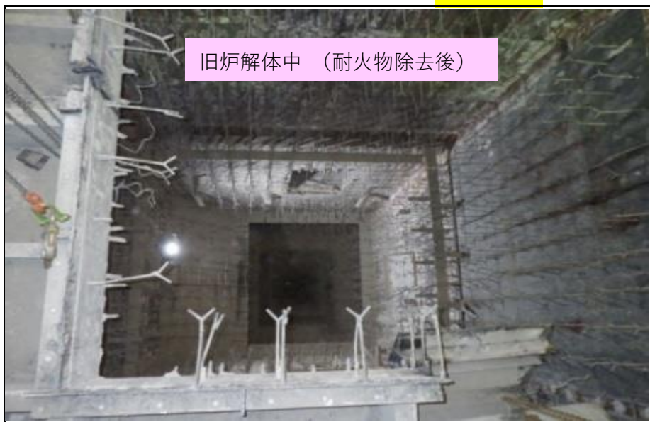
焼却炉上部切断部より下方向を撮影
