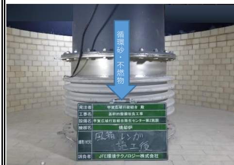
風箱レンガ施工①
