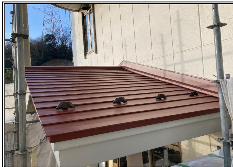
工場棟1階玄関屋根
