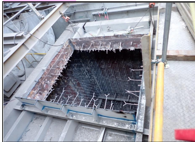
①連絡ダクト解体
