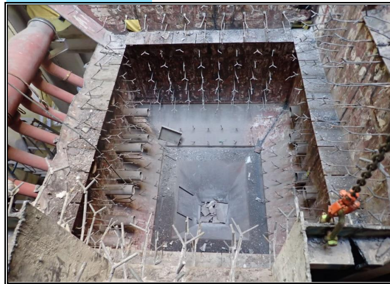
③焼却炉下部解体
