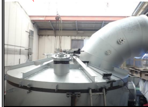
焼却炉天井部
