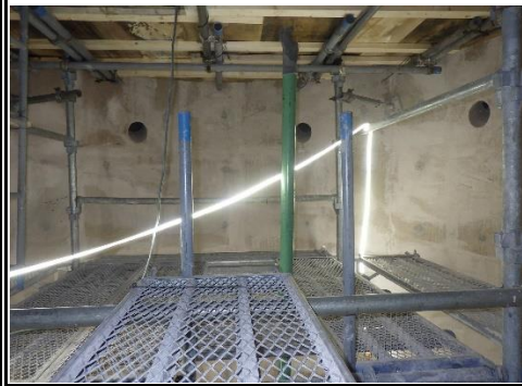
ガス冷却室耐火物打設 (4階部分)
