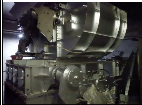
ゴミ破砕機 据付
