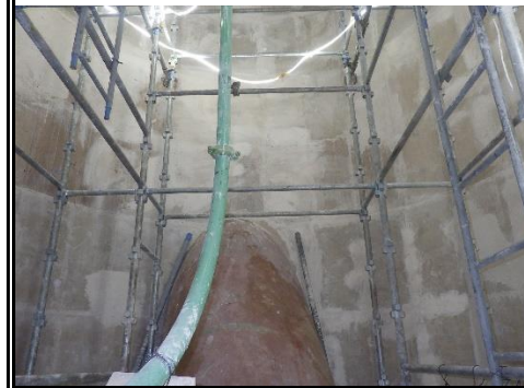
ガス冷却室耐火物打設 (2階部分)
